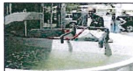
Eine biologische Kleinkläranlage. Archiv-Foto: P. Cissek
